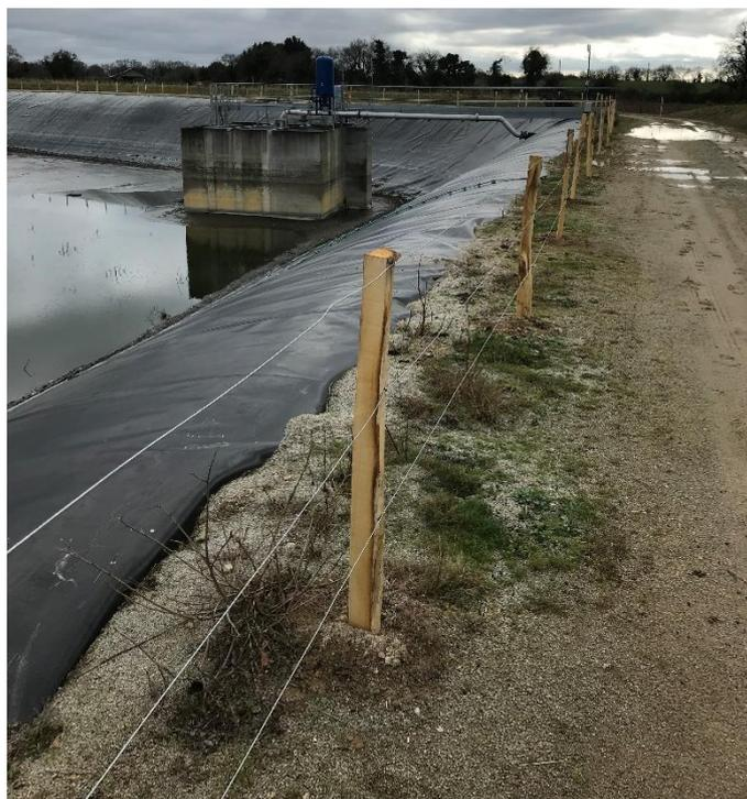
Figure 6 : mise en place de clôtures en têtes de lagunes
