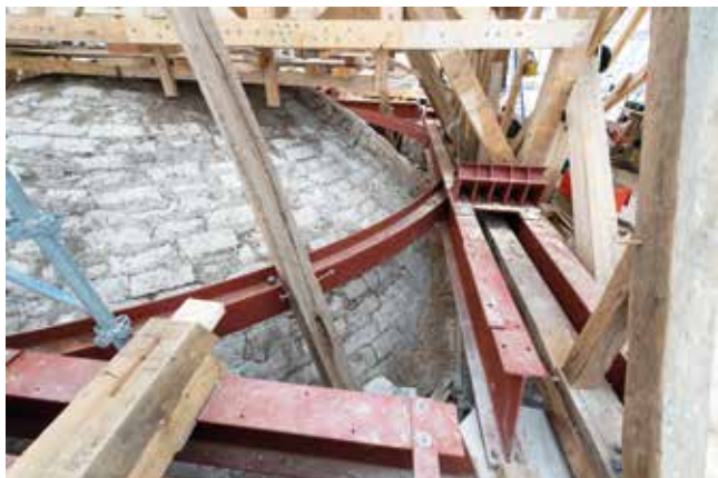
Pose des poutrelles métalliques
