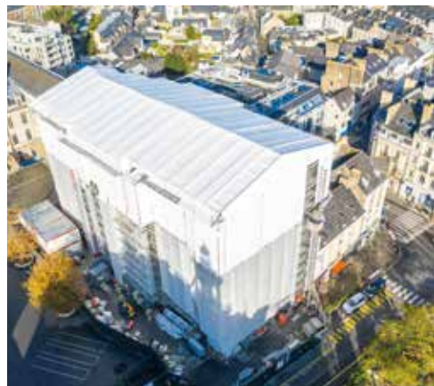
Vue aérienne du chantier
