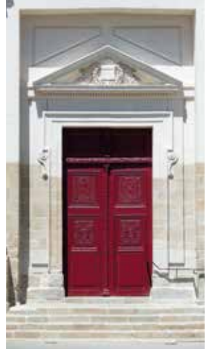
Porte d'entrée de la chapelle
