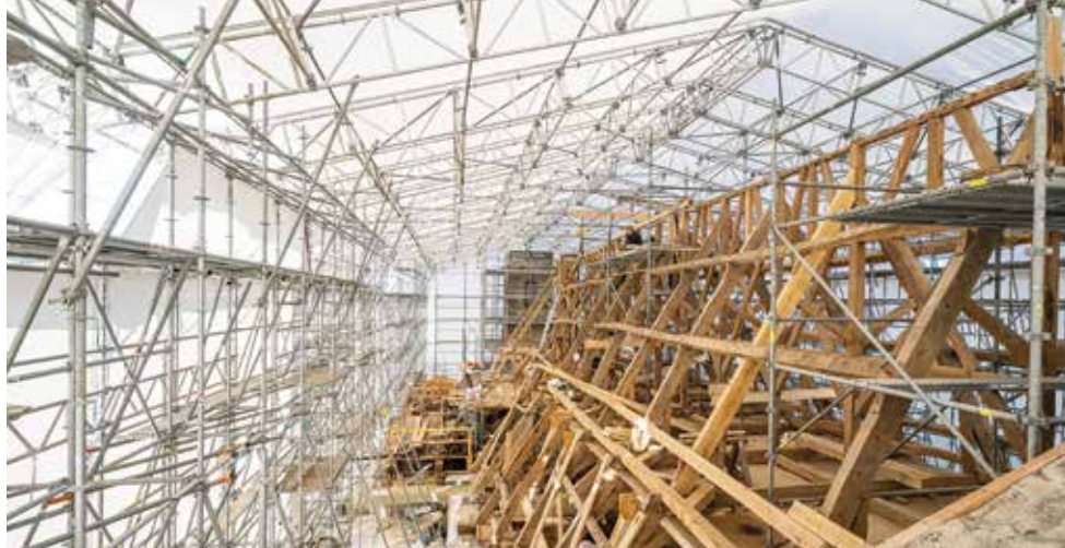
Charpente, vue générale
