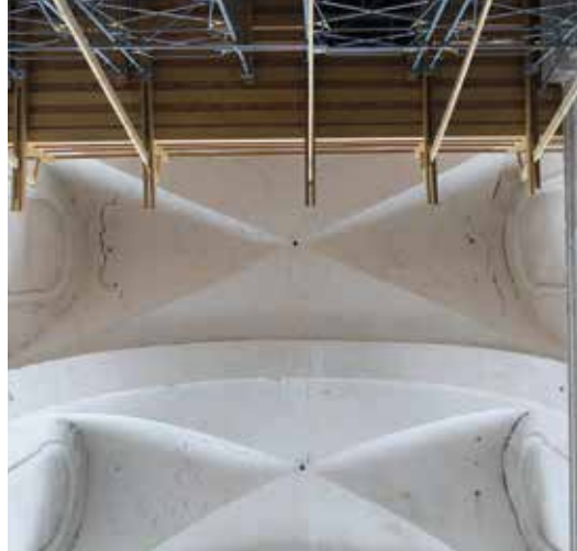
État des voûtes avant restauration
