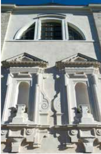
Niches, façade sur cour
