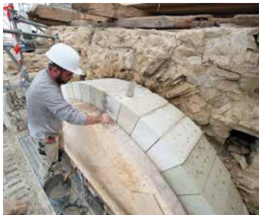
Pierres d'encadrement des baies
