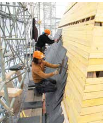
Dépose de la couverture existante et pose des ardoises de Galicie
