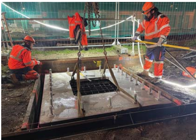
La pose des fondations sur quai de la passerelle qui enjambrera les rails a été finalisée en avril.
