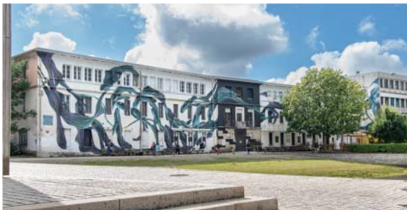
L'ancien bâtiment de la DDTM occupé par le B.R.E.F, laissera place à un nouveau projet à partir de 2025.
