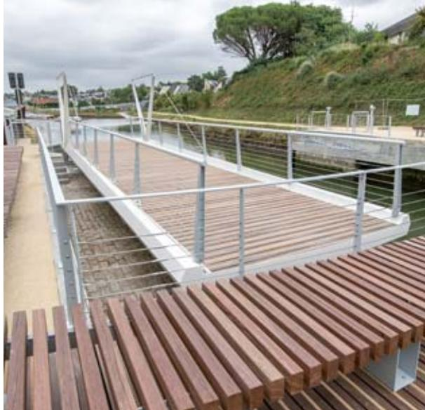
La passerelle pivote et se range dans le coffre pour permettre le passage des bateaux.
