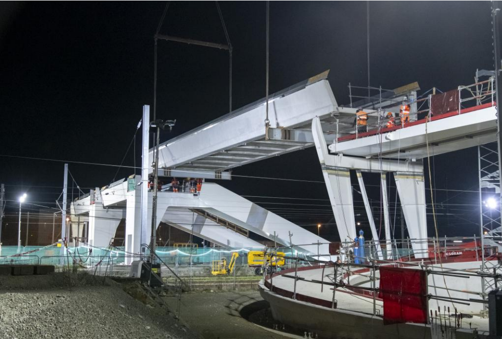
Grutage des trois tabliers de la passerelle
