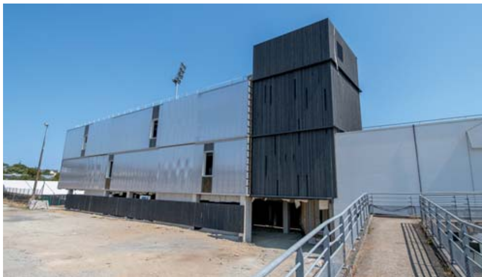
Le chantier pour l'espace du golfe ne s'est pas arrêté cet été, et sera livré le 3 octobre.
