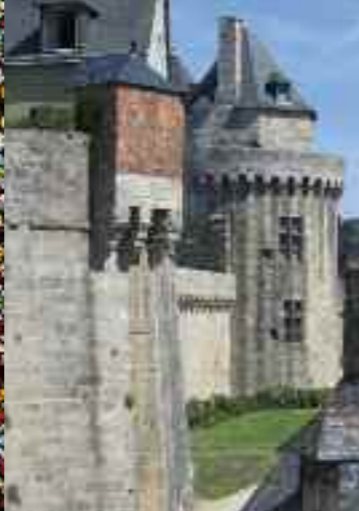
La tour du Connétable, construite au XV e siècle, présente une élévation remarquable qui autorisait la surveillance du plateau de la Garenne.
