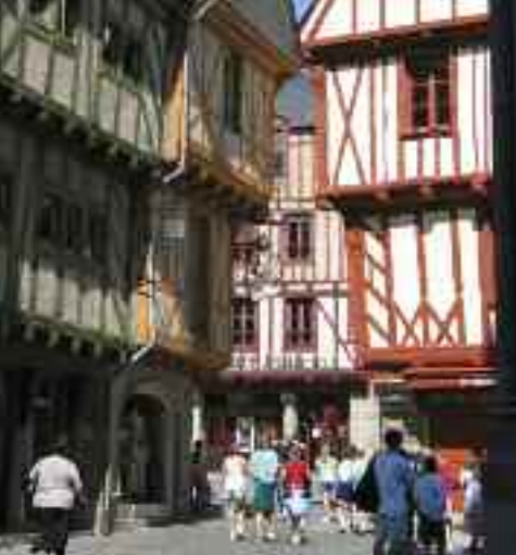
Vue de la place Saint-Pierre. L'ossature en charpente des maisons à pans de bois participe souvent au décor des façades.
