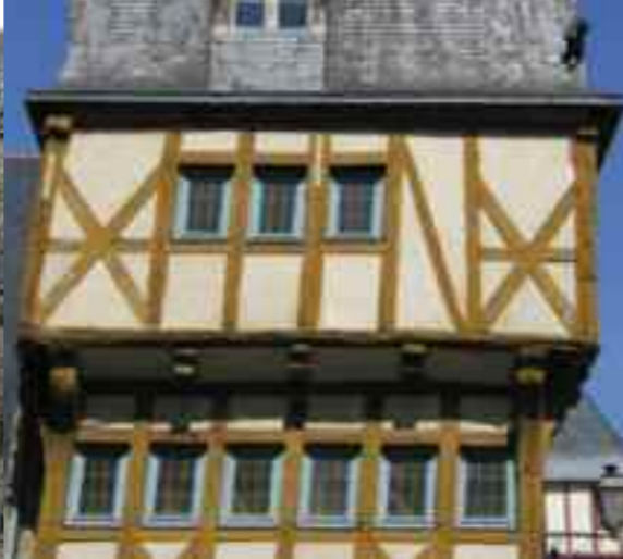
Place Saint-Pierre, les maisons à pans de bois les plus anciennes présentent un éclairage horizontal composé d'une succession de petites fenêtres.
